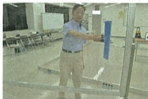
ガラス面洗浄作業
